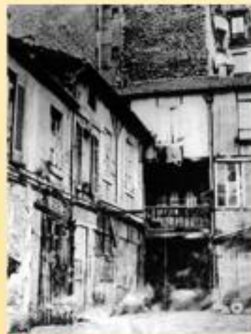
Ngôi nhà số 9, ngõ Công Poanh (Compoin), nơi ở của Nguyễn Ái Quốc từ năm 1921-1923.
